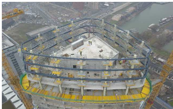
Polyfunkčný súbor EUROVEA 2, stavba č. 05 – Bytový dom/Veža Dodávka a montáž OK korunky veže
