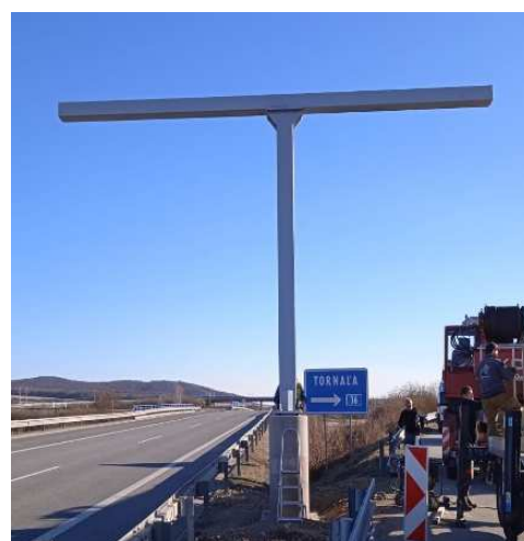
Zvyšovanie pasívnej bezpečnosti na cestách 1. triedy v Banskobystrickom kraji Dodávka a montáž 15 ks portálov dopravného značenia
