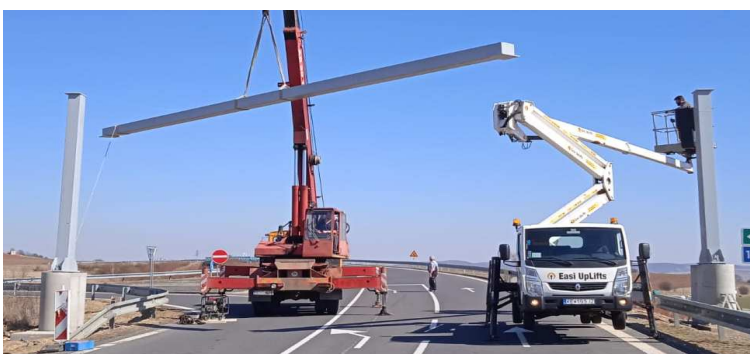
Zvyšovanie pasívnej bezpečnosti na cestách 1. triedy v Banskobystrickom kraji Dodávka a montáž 15 ks portálov dopravného značenia
