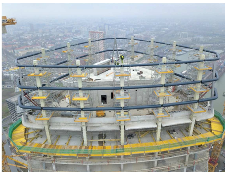
Polyfunkčný súbor EUROVEA 2, stavba č. 05 – Bytový dom/Veža Dodávka a montáž OK korunky veže
