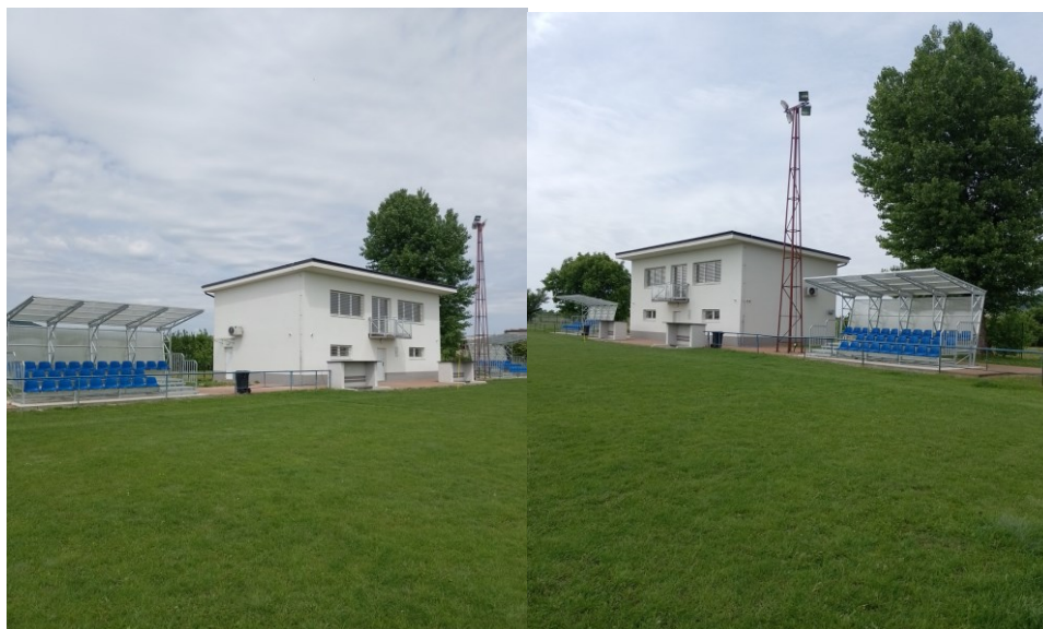
Budova pre mládež a šport a tribúny na ihrisku TJ
