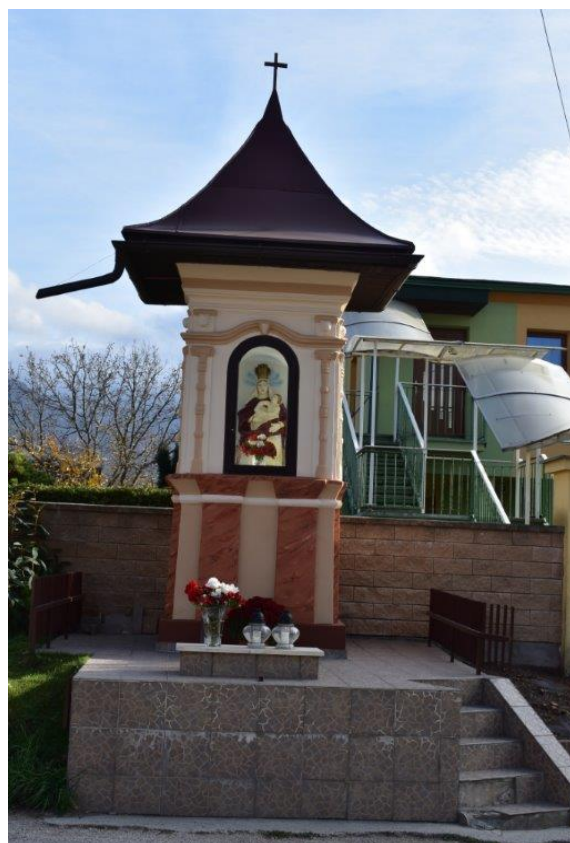
Obnovená kaplnka v roku 2018
