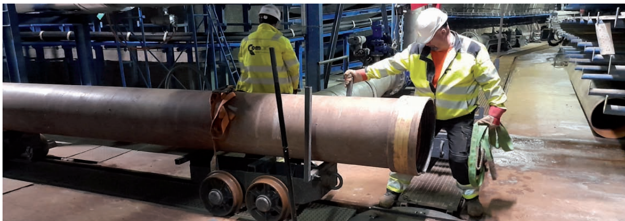
Brno, Kolektor - rekonštrukcia vodovodu
