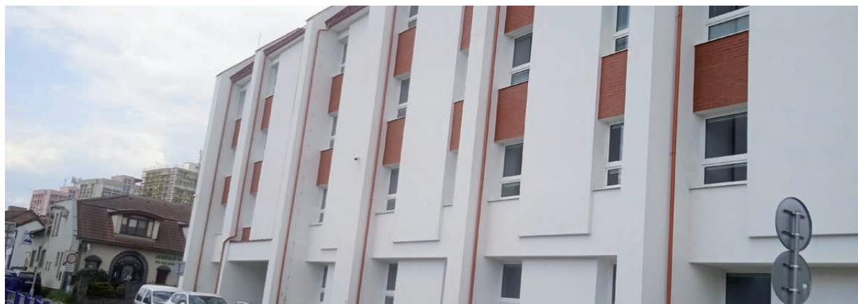
Lučenec - obnova Okresného súdu
