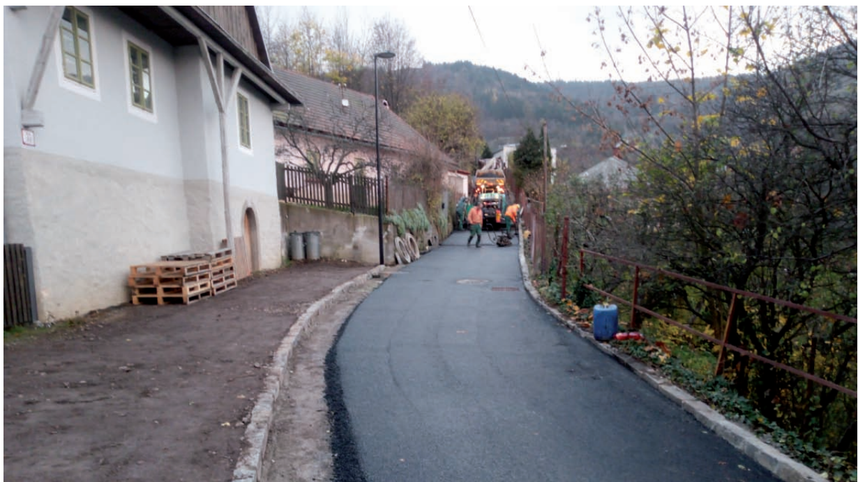
Banská Štiavnica - Dolná Resla - rekonštrukcia miestnej komunikácie
