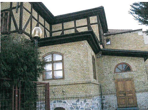
Staničný dom, začiatok 20. Storočia
