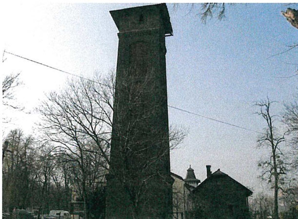
Aréna – dom strojníka vodárenskej veže
