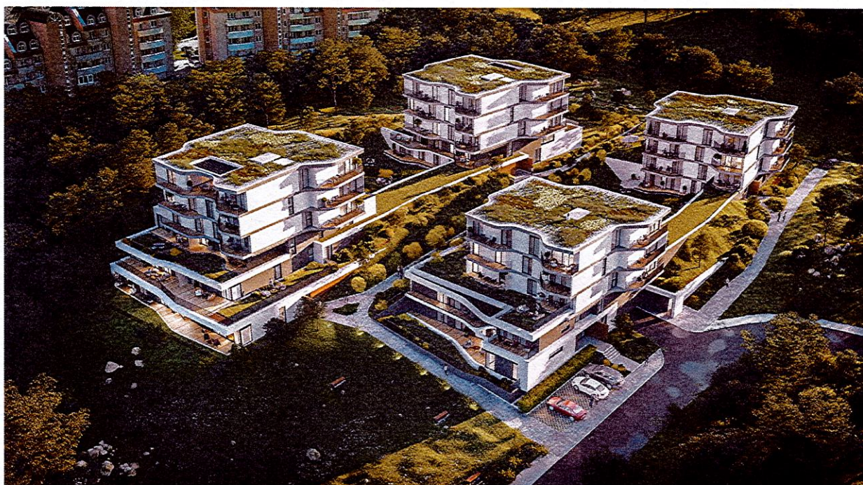
STRABAG Pozemné staviteľstvo – VILLA RUSTICA TERASY
