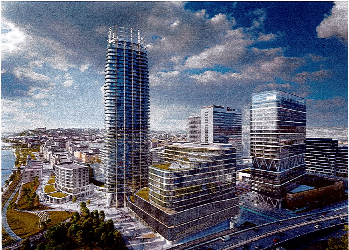
Pribinova Y – administratívna budova
