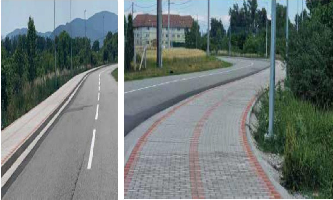
Obrázok: chodník spojený s cyklochodníkom a verejným osvetlením od futbalového ihriska smerom na obec Milhost'.
