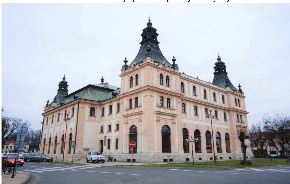
Obrázok č. 19: Reduta – príprava komplexnej obnovy objektu - 1
