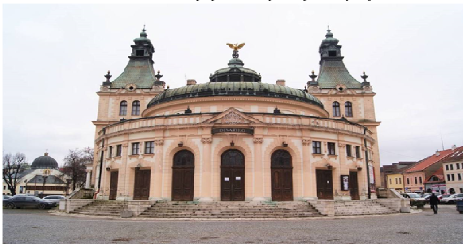
Obrázok č. 20: Reduta – príprava komplexnej obnovy objektu - 2
