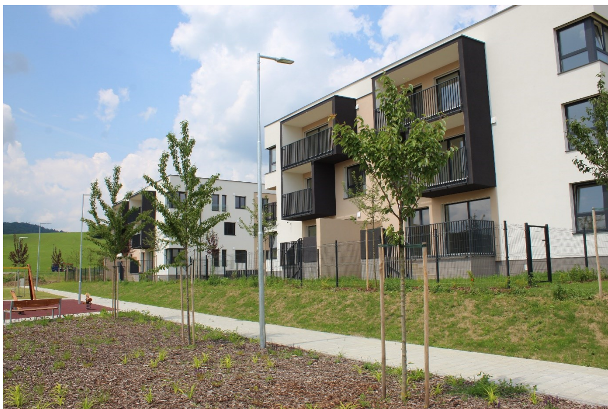
6 bytových domov, I. etapa, Bardejov
