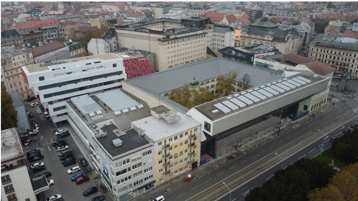
Zrekonštruovaná a zmodernizovaná budova SNG, Bratislava
