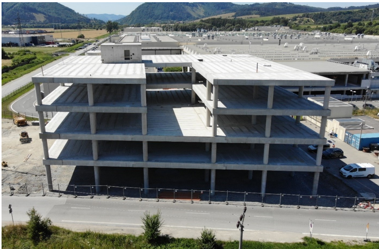
Rozšírenie Schaeffler Kysuce, Kysucké Nové Mesto
