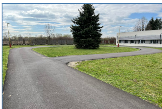
Renovovaný asfaltový povrch
