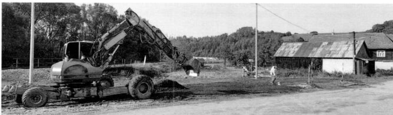
Dokončovacie práce na projekte „SKK a ČOV Chlebnice, Dlhá nad Oravou a Sedliacka Dubová – časť odkanalizovanie obce Dlhá nad Oravou“ spolufinancovaný Európskou úniou z Integrovaného regionálneho operačného programu IROP. Projekt bol v roku 2023 ukončený a skolaudovaný dňa 13.12.2023.
