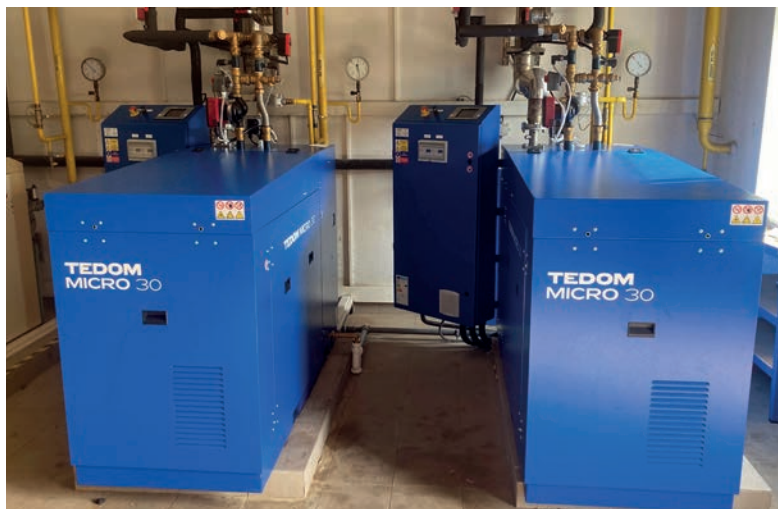
V rámci investičného plánu 2023 boli na ČOV Námestovo osadené dve kogeneračné jednotky, ktoré zabezpečia vyššiu efektívnosť a úsporu energií.
