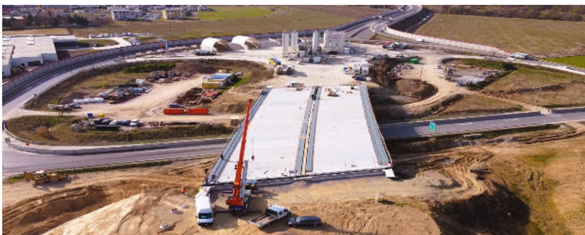
Pohľad na križovatku Kriváň s mostom SO 225-00 na začiatku úseku
