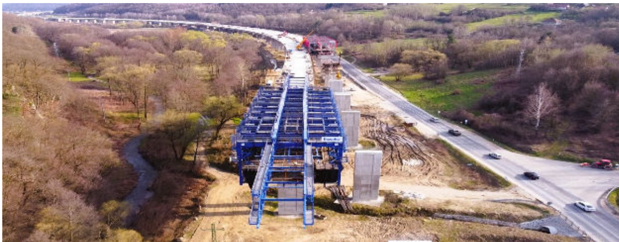
Pohľad na výstavbu mostného objektu SO 210-00 a zrealizovanú preložku cesty I/61 vpravo
