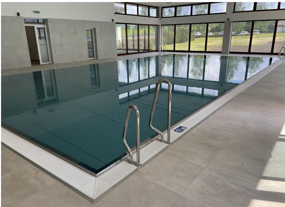
Rekonštrukcia bazénovej časti v budove Clubhouse v obytnom súbore Krasňany
