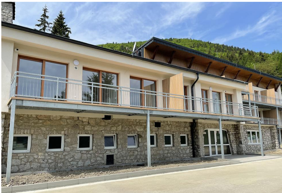
Prestavba hotela Kľak na apartmány
