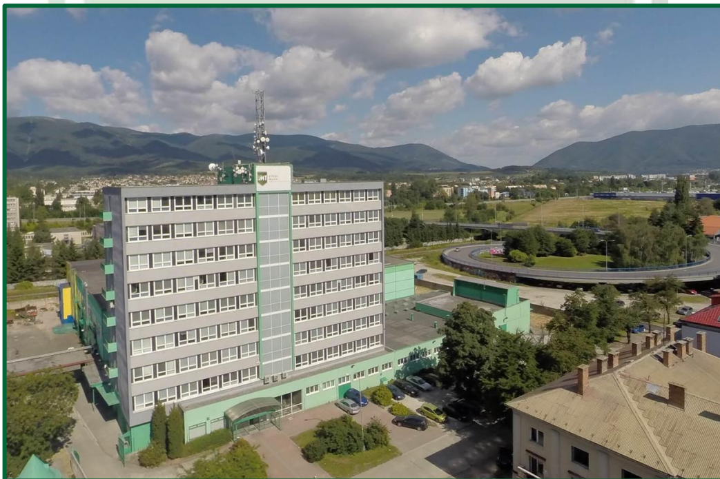
Pohľad na administratívnu budovu
