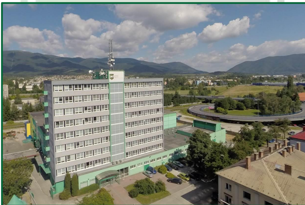
Pohľad na administratívnu budovu
