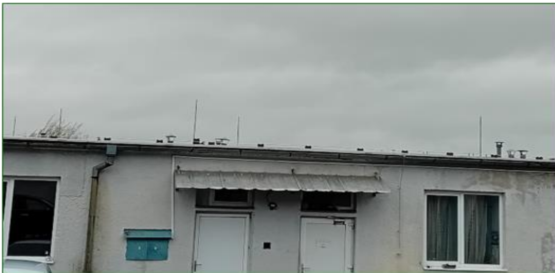
Rekonštrukcia elektroinštalácie – stredisko TS
