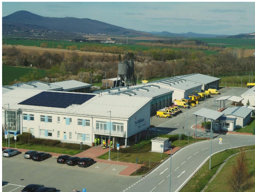
Obr. X Fotovoltaické panely na stredisku údržby
