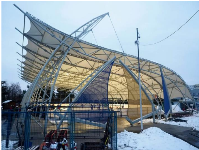
Obr. 15 Prestrešenie ľadovej plochy na ŠZA
