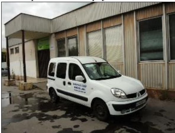
Obr. 34 Jedáleň pre dôchodcov, Vojvodská 5 pôvodný stav
