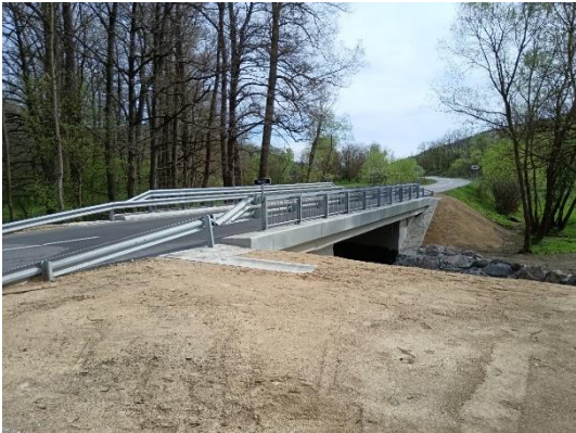
Most M81, evid. č. 591-016, po realizácii
