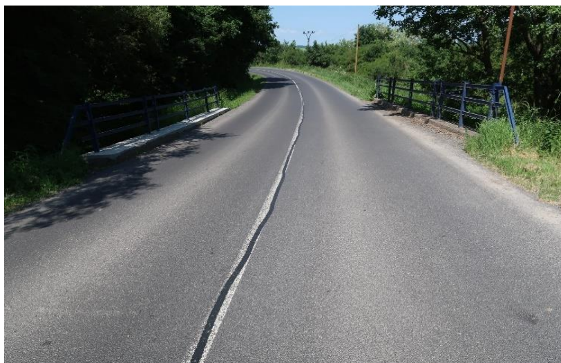
M5598, evid. č. 2741-008 Most cez Sokolí potok pred obcou Husiná – oprava rímsy a náter zábradlia
