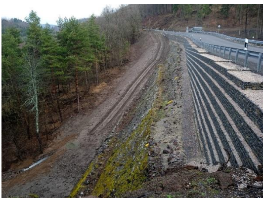
Cesta II/591 v okr. DT , Taras po realizácii
