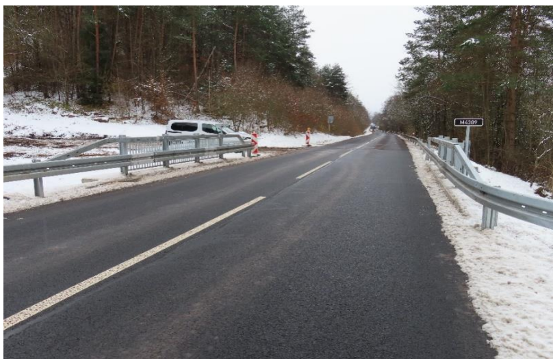
Most M4389, evid. č. 591-009, po realizácii
