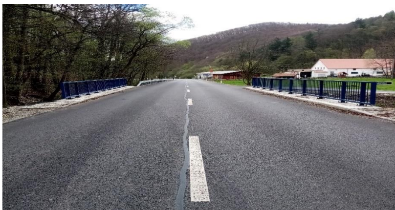
Most M3652, evid. č. 512-017, po realizácii
