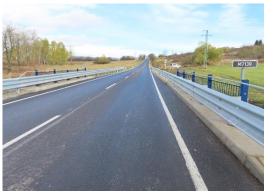
Most M7139, evid. č. 526-009, po realizácii
