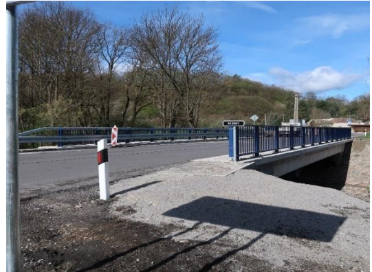
Most M3561, evid. č. 591-005, po realizácii
