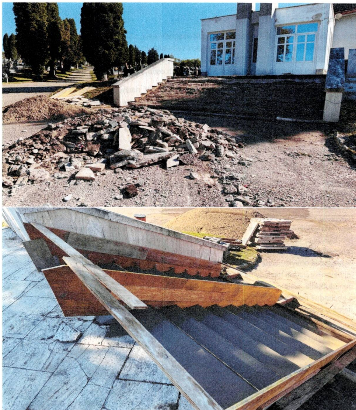
Stavebné práce na stavbe „Schodisko – Dom Nádeje- cintorín Lipina“
