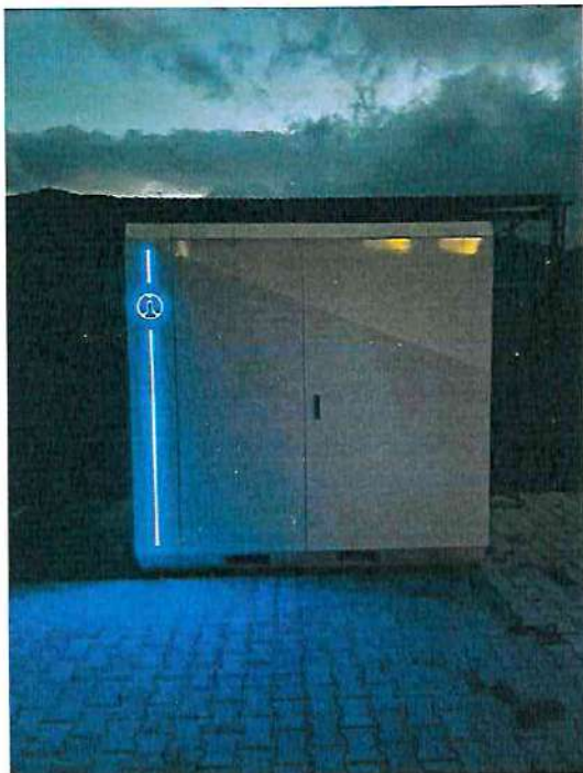
Batériové úložisko Terra 100 kW/150 kWh
