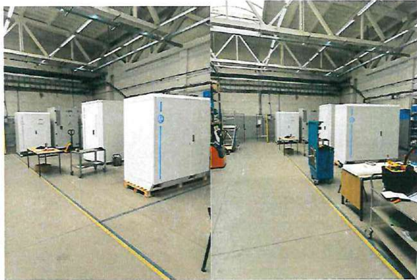
Prestavba baliarne na montáž energetických batériových systémov
