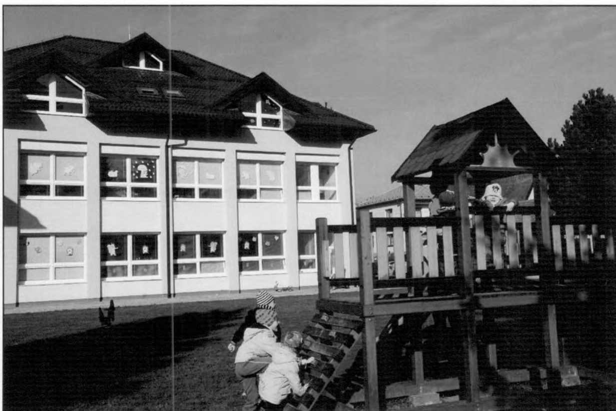
Budova MŠ po rekonštrukcii
