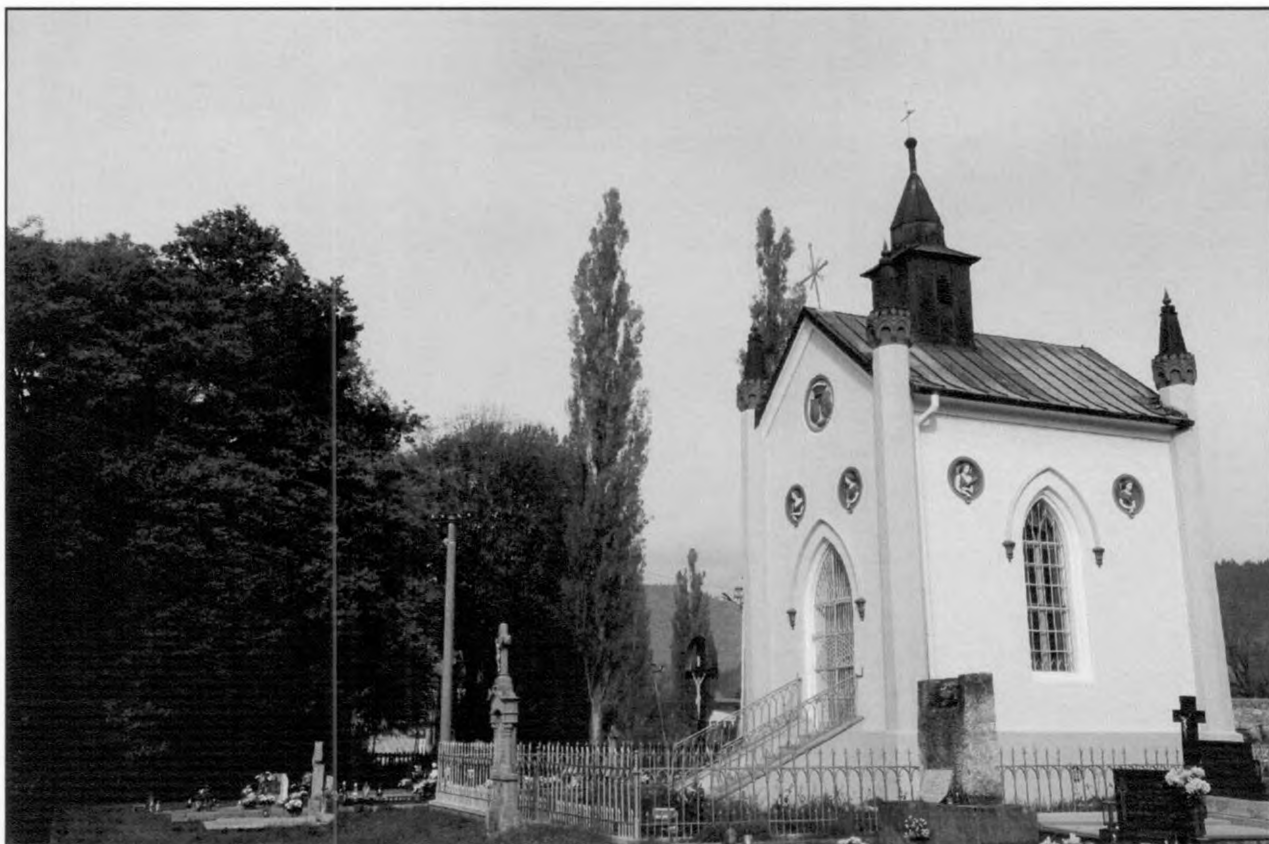
Zrekonštruovaná kaplnka na cintoríne
