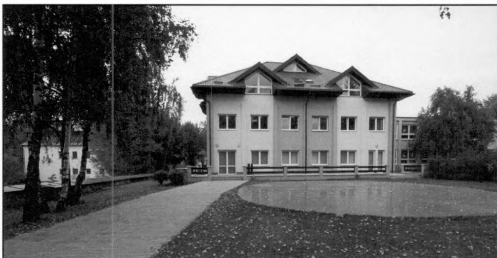
Budova kultúrneho domu po rekonštrukcii
