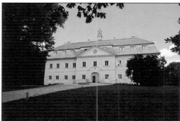
Hotel po rekonštrukcii
