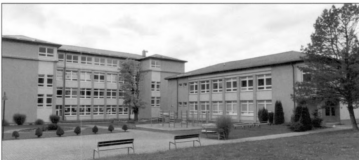
Budova Základnej školy v Gbelanoch a školskej jedálne
