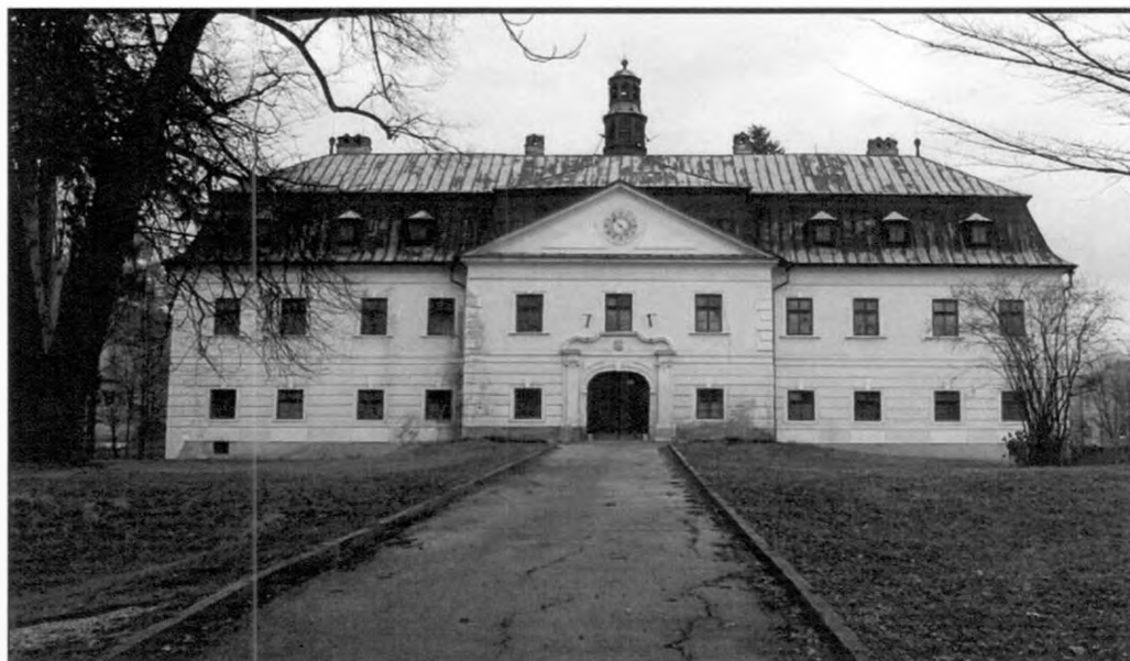
Budova barokového kaštieľa pred rekonštrukciou
