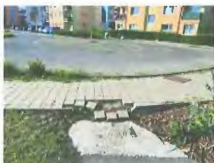
Oprava chodníka na ul. Komenského
