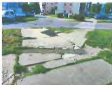
Oprava chodníka na ul. Dolnomajerská
