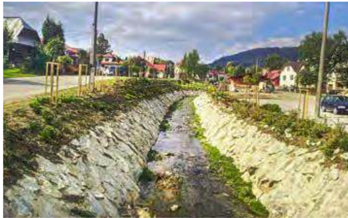
Stavba: "Ochrana pred povodňami"
