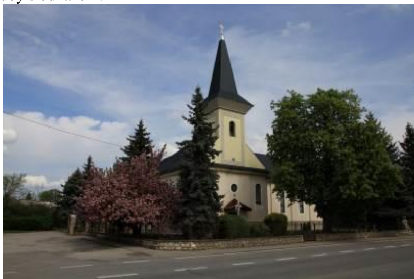
Obr. č. 2: Dnešný pohľad na rímskokatolícky kostol
