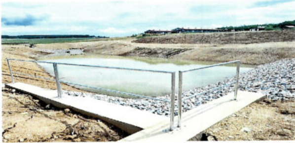
Nádrž na ochranu pred povodňami
