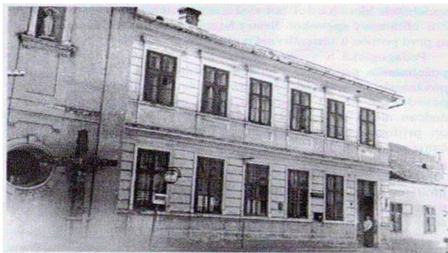
Budova kláštora sestier svätého Kríža v Pečeňadoch
