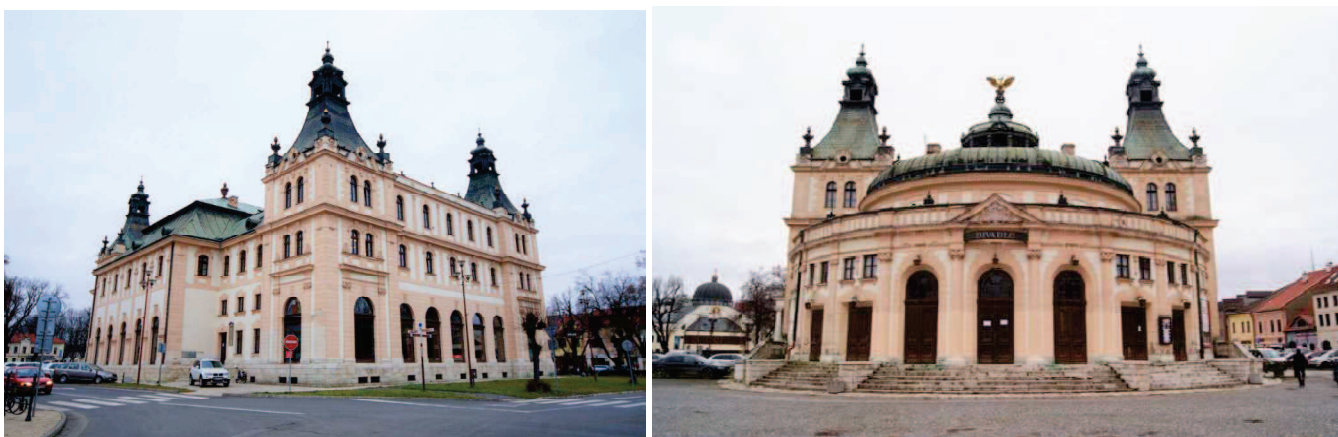
Obrázok č. 33 Reduta – príprava komplexnej obnovy objektu
