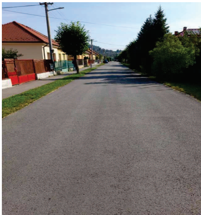
Obrázok č. 19 Rekonštrukcia miestnej cesty na ul. Tolstého
