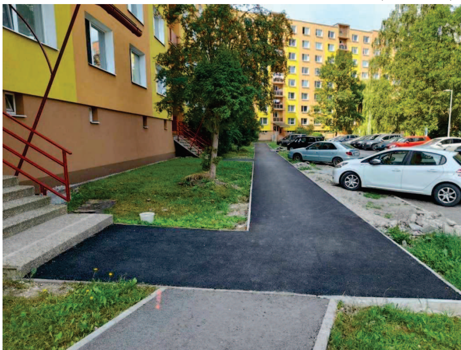
Obrázok č. 53 Rekonštrukcia rozvodov ÚK a TV – okruh kotolne Mier 1, vetva sever, časť 3
