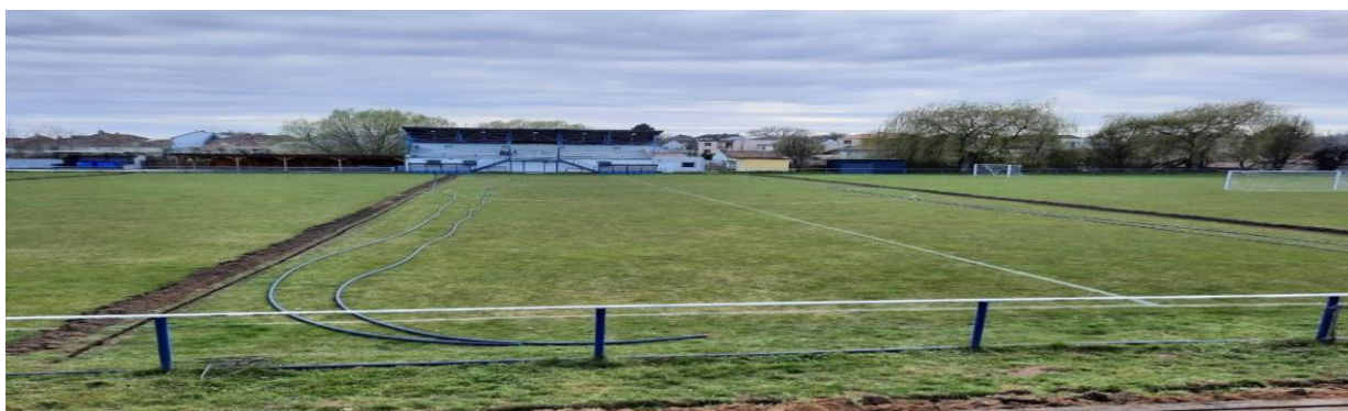
Realizácia zavlažovacieho systému
