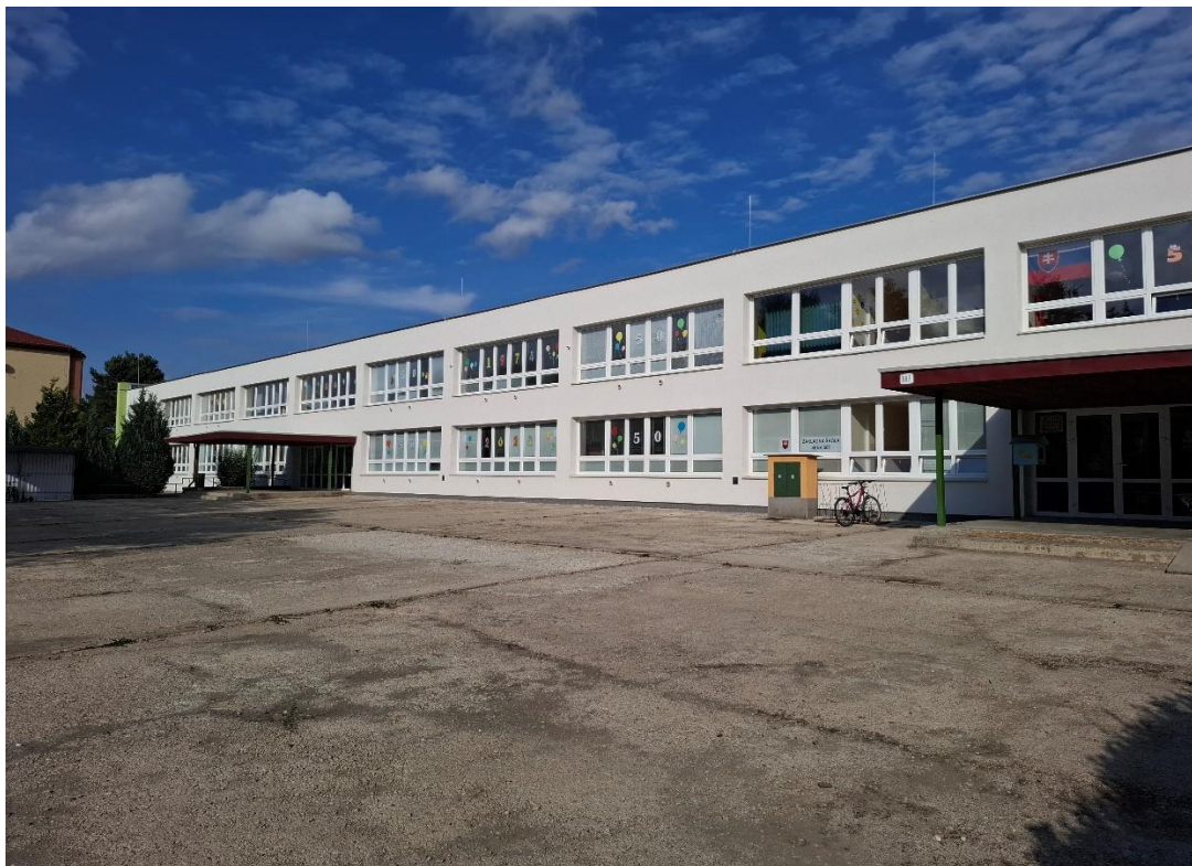
Základná škola Seňa po rekonštrukcii
