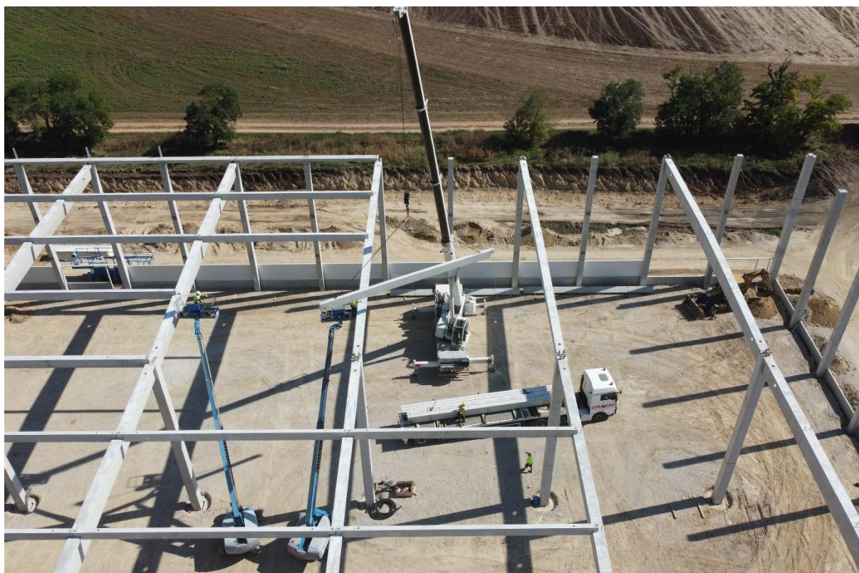
Montáž prefabrikovaného železobetónového skeletu pre spoločnosť CTPark, Voderady
