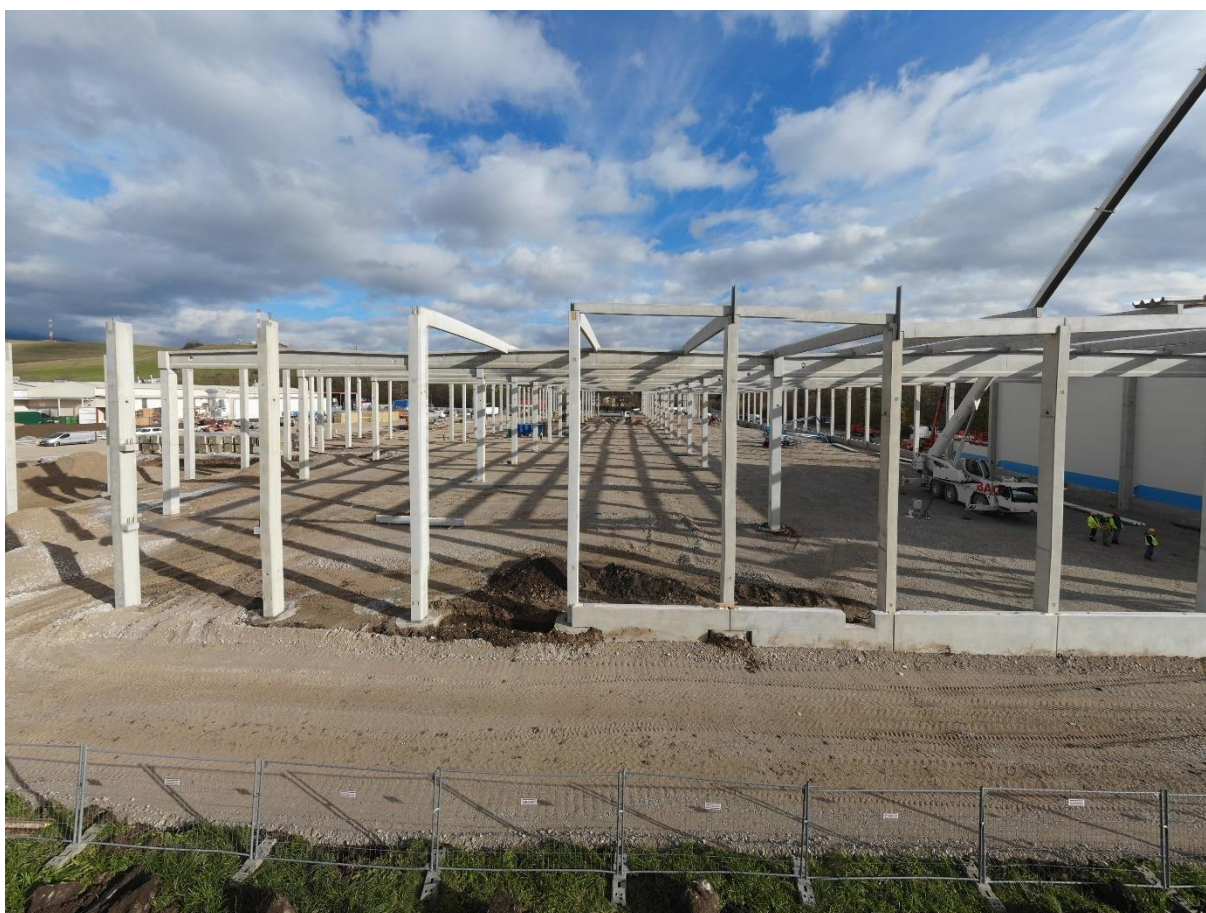
Montáž prefabrikovaného skeletu haly pre spoločnosť HOVAL, Istebné
