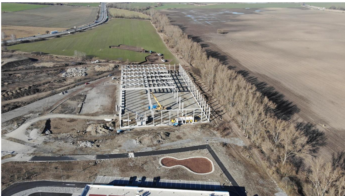
Montáž prefabrikovaného železobetónového skeletu pre spoločnosť VGP, Zvolen
