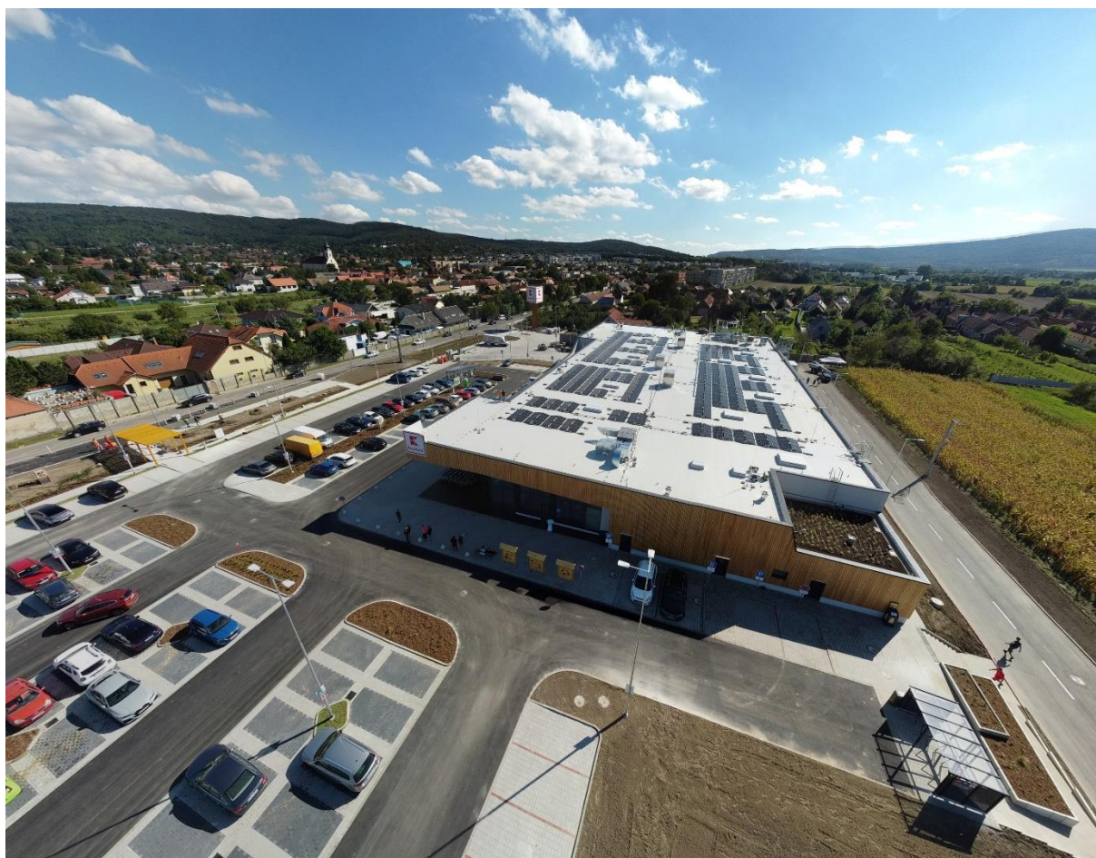
Obchodné centrum KAUF LAND, Záhorská Bystrica
