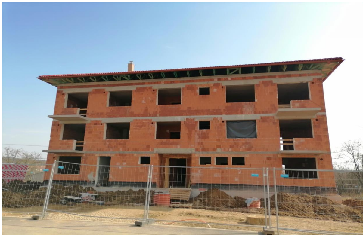
Obrázok 1 Výstavba nájomných bytov na ulici Mlynskej
