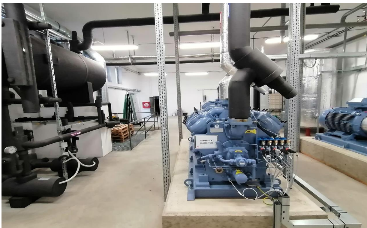
Obrázok 2 Rekonštrukcia Zimného štadióna – I. etapa
