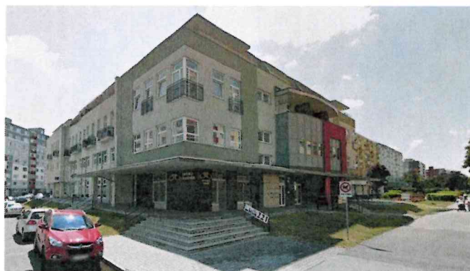
Objekt 221 na Poľnohospodárskej ulici
