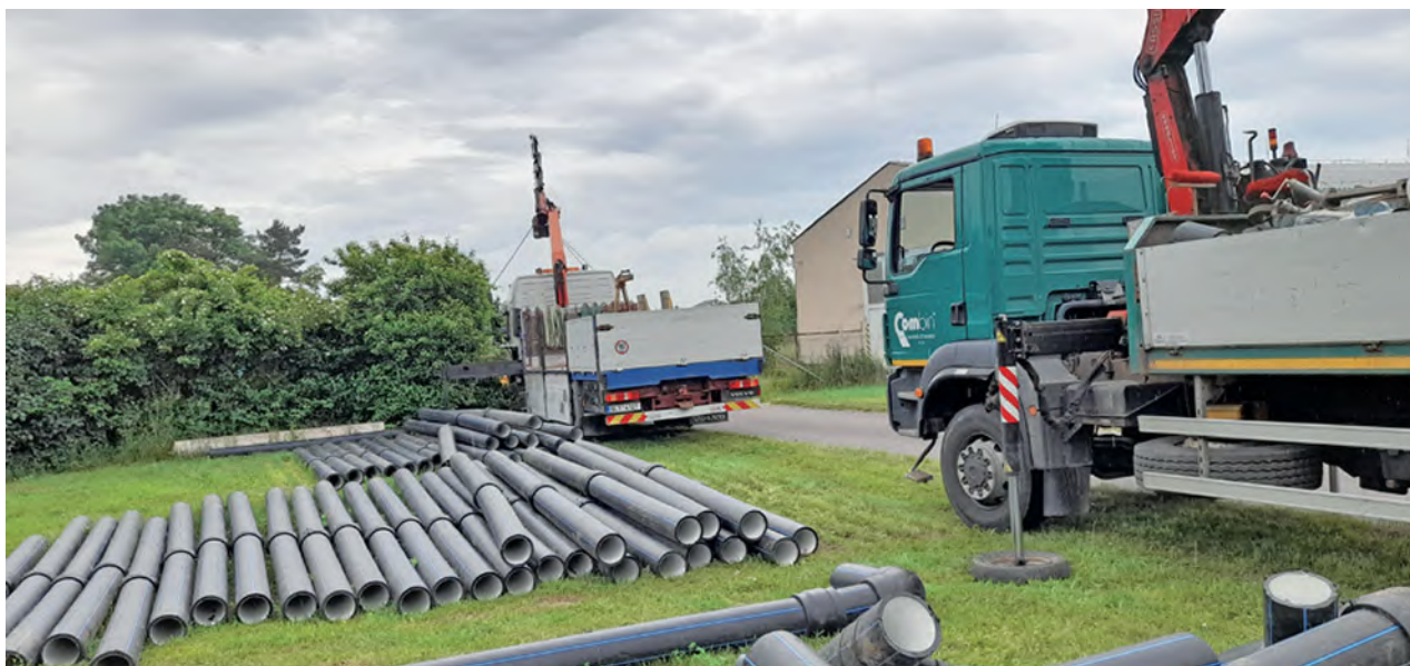
Brno kolektor - rekonštrukcia vodovodu
