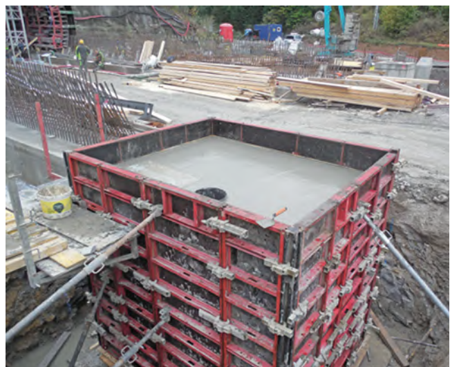
Čebrať - tunel, požiarneho vodovodu
