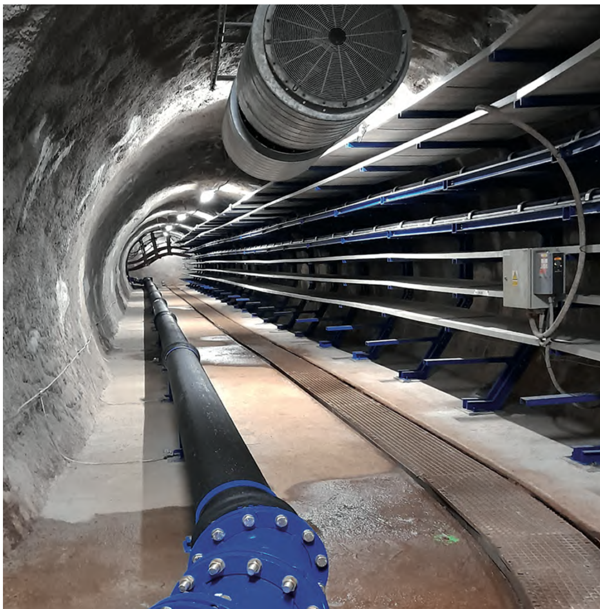
Bmo kolektor - rekonštrukcia vodovodu
