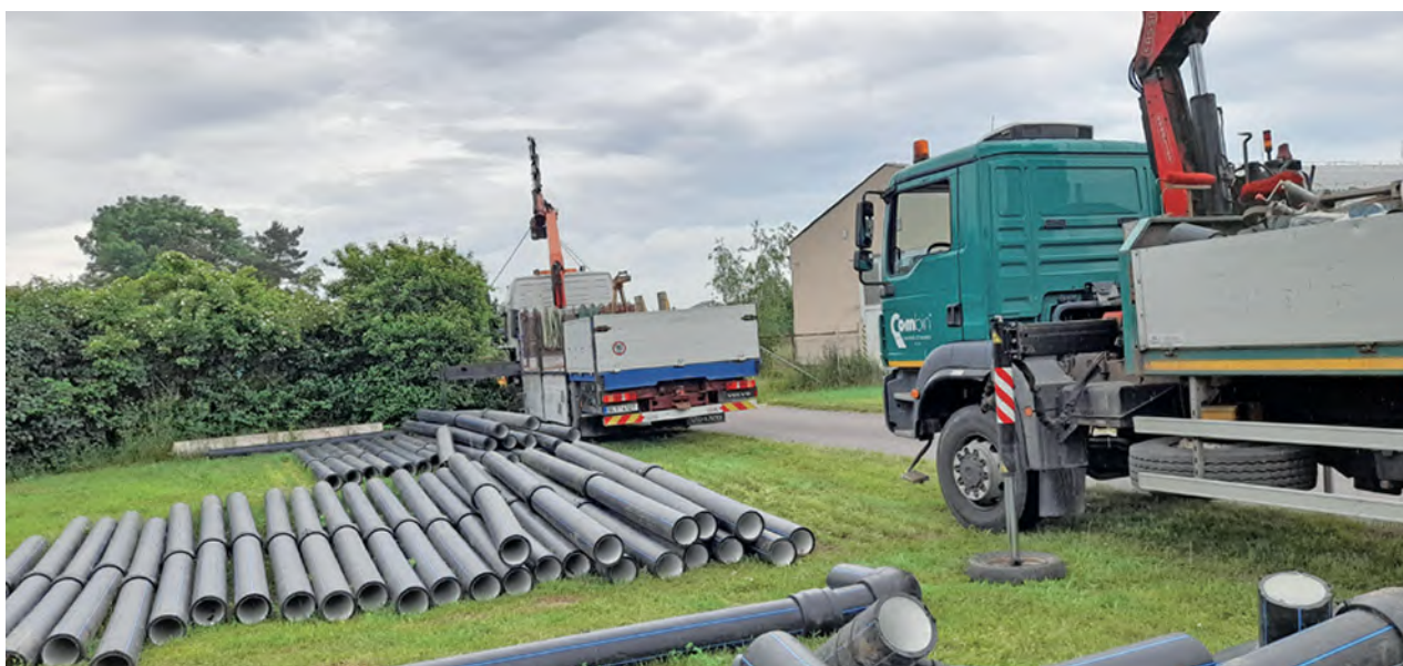
Brno kolektor - rekonštrukcia vodovodu
