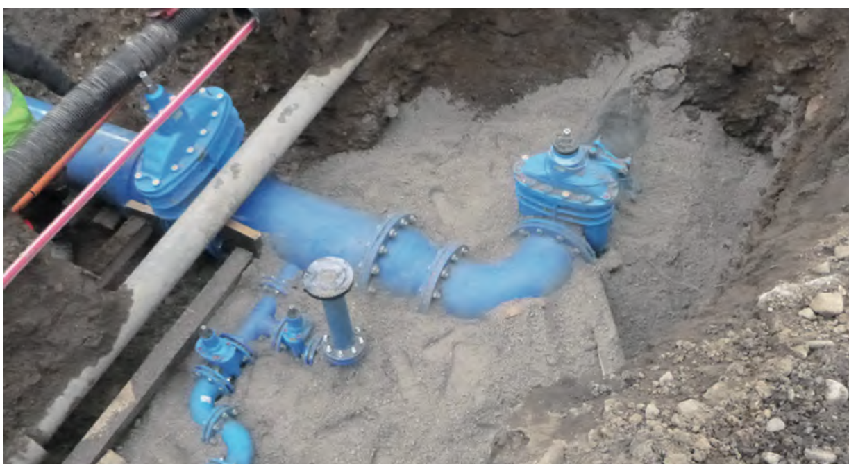
Grinava – Pezinok, oprava potrubia
