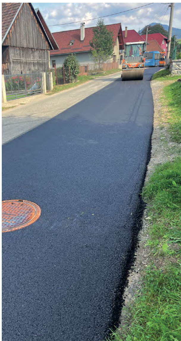
Žaškov, Orava - odkanalizovanie obcí
