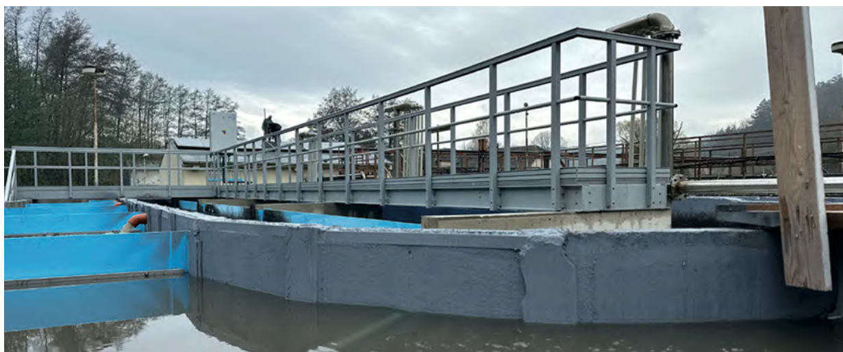
Krajnė - modernizácia ČOV
