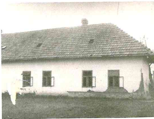
Budova, v ktorej bola v Plavých Vozokanoch zriadená prvá jednotriedna cirkevná škola
