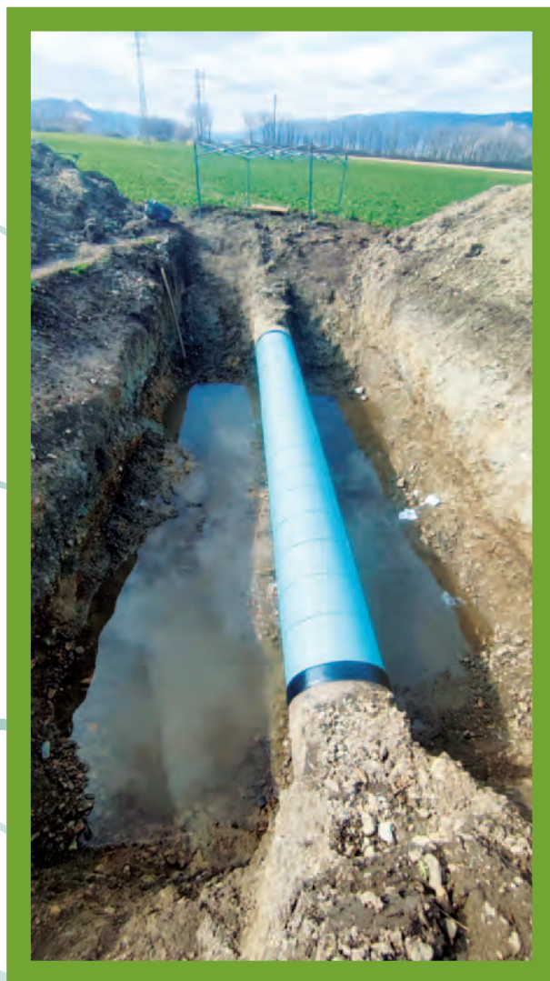
Obr.: Rekonštruovaný stožiar RR bodu a jedna z lokalít v rámci rekonštrukcie izolačného systému potrubí na trase ropovodu
