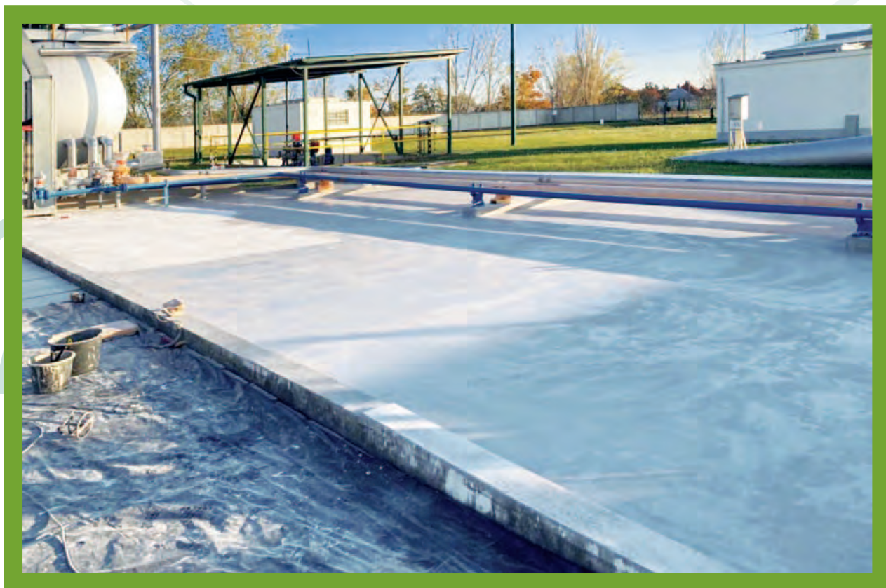
Obr.: Rekonštrukcia stáčacích plôch v PS 5 Bučany
