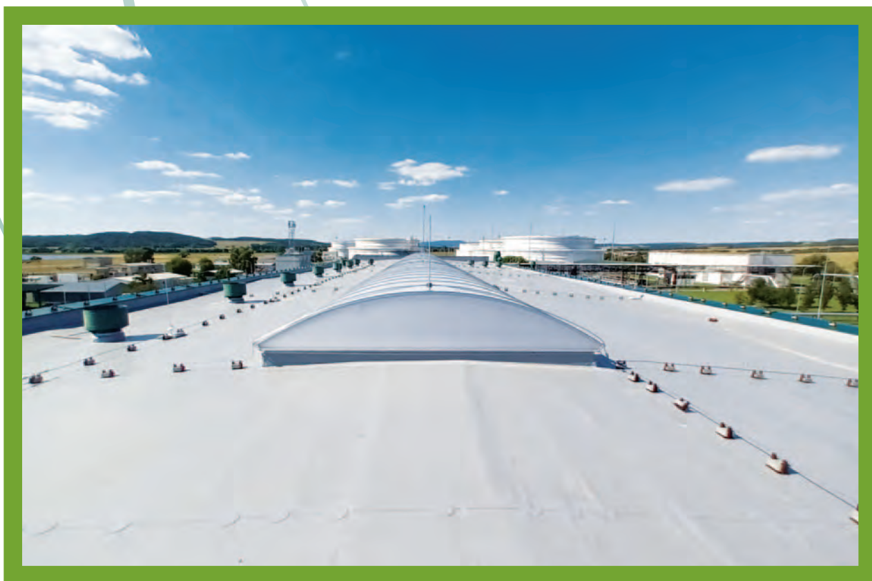
Obr.: Zrekonštruovaná strecha Dielni ADRIA v PS 4 Tupá
