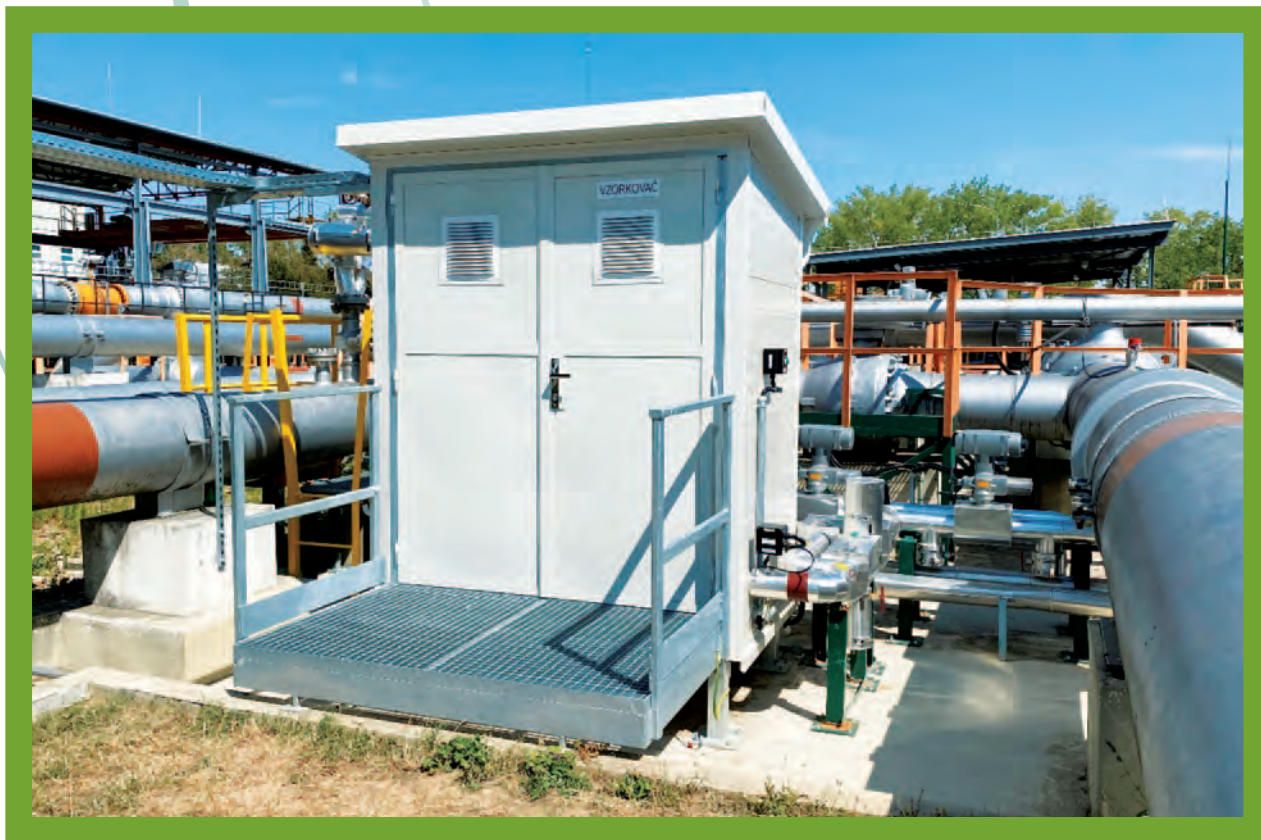
Obr.: Modernizovaný vzorkovač ropy v PS 5 Bučany
