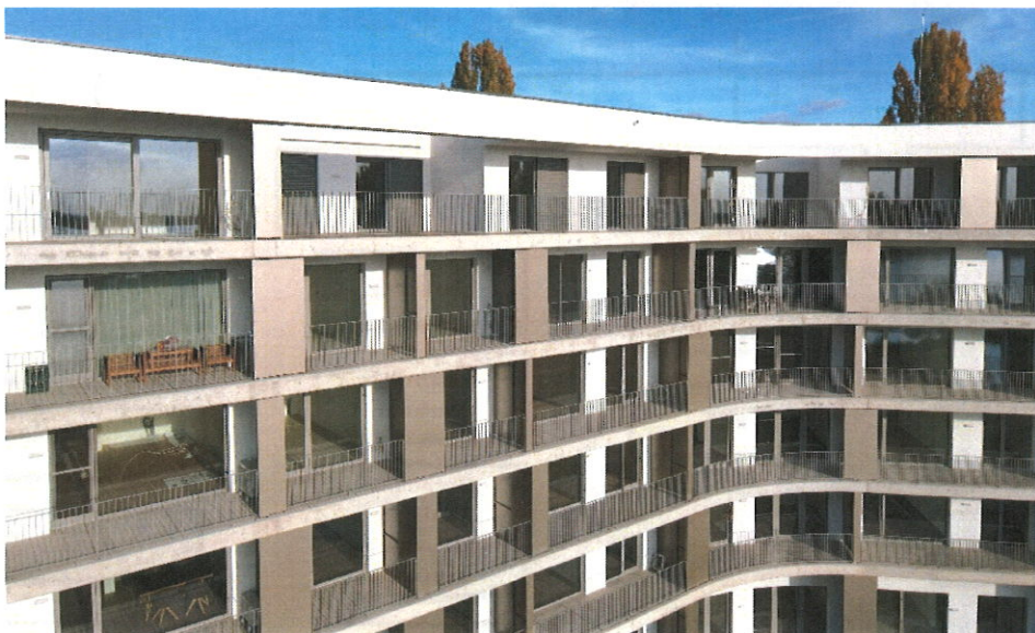
Realizácia 2023: Bytový dom Piešťany
