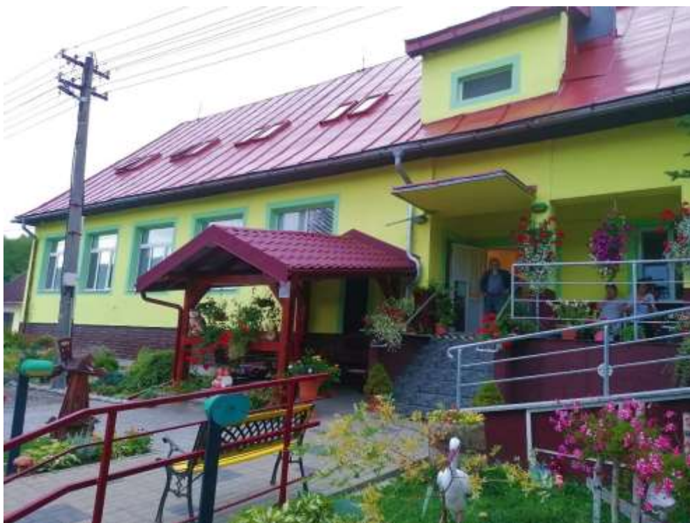
Obr. 1 Budova zariadenia pre seniorov – GERIA, n. o.
