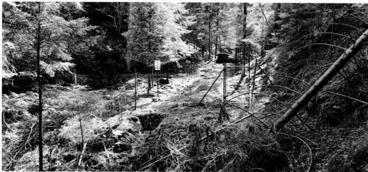
Stav pred poškodením
