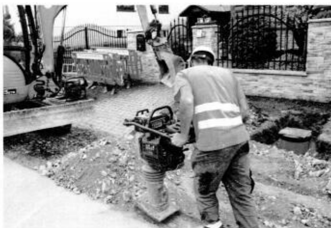
Pripájanie nehnuteľností na verejnú kanalizáciu v obciach Žaškov, Párnica a Dlhá nad Oravou. Cieľ zabezpečiť pripojenosť 60% za rok 2024 sa podarilo naplniť. Bolo pripojených viac ako 580 nehnuteľností.
