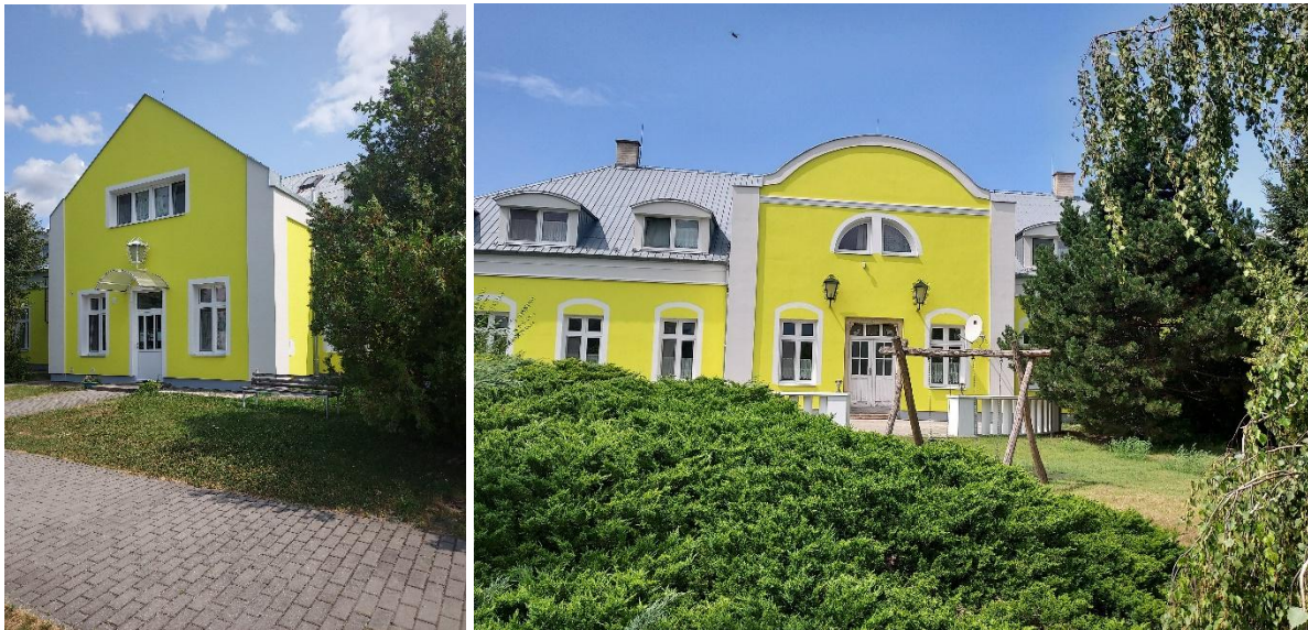
Obnovená - izolovaná budova CDR
