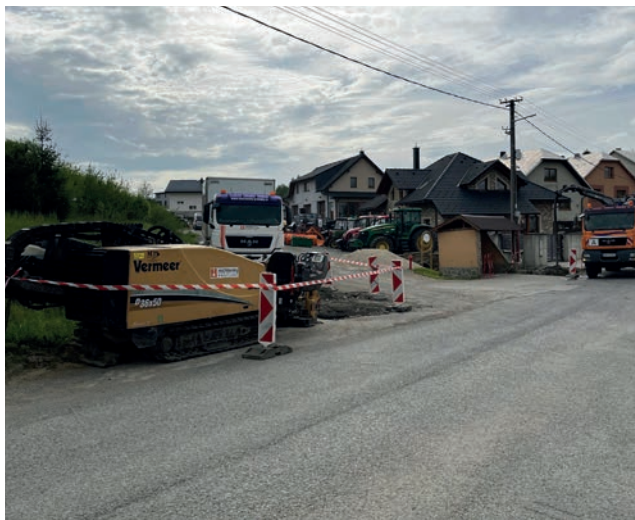
Výstavba kanalizácie v obci Brezovica. Bezvýkopová technológia riadeného pretlaku
