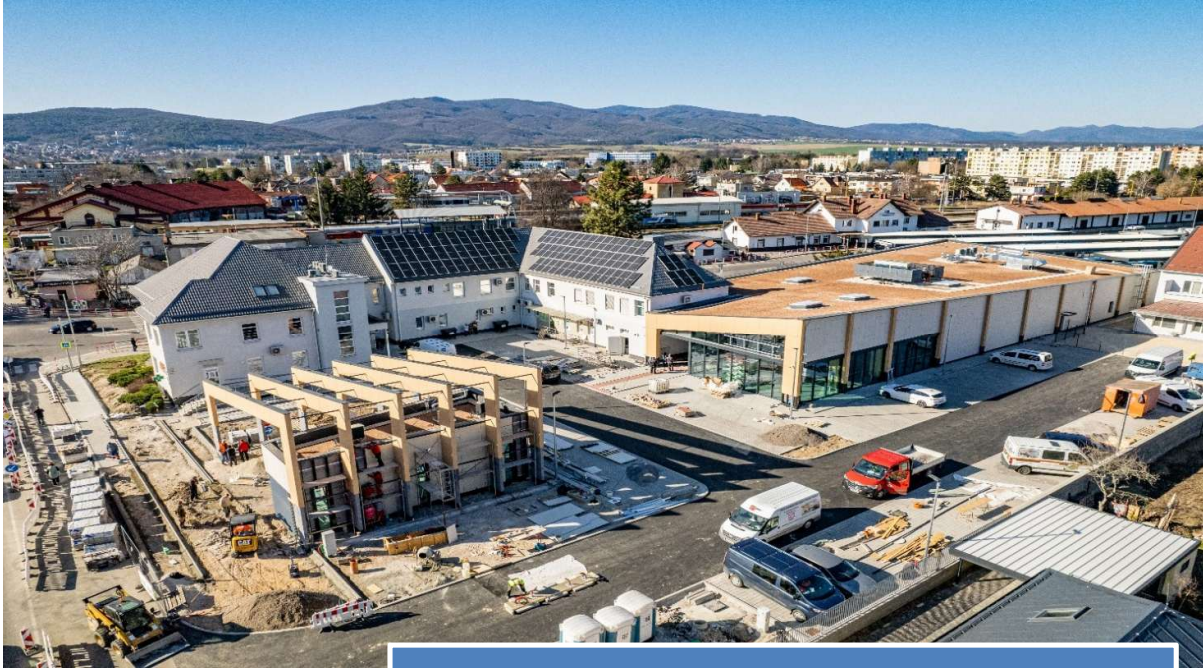
Aktuálny stav prebiehajúcej výstavby PJ 210 na ul. A. Hlinku
