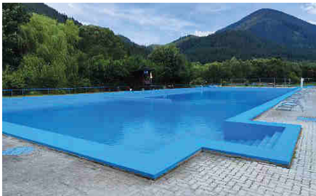
Zrekonštruované letné kúpalisko Hotelu Máj v Liptovskom Jáne
