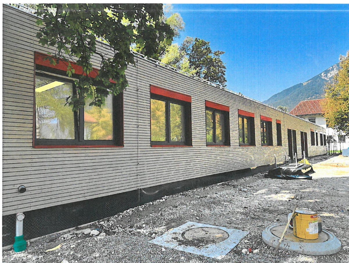
Polyfunkčná budova Reichenhall
