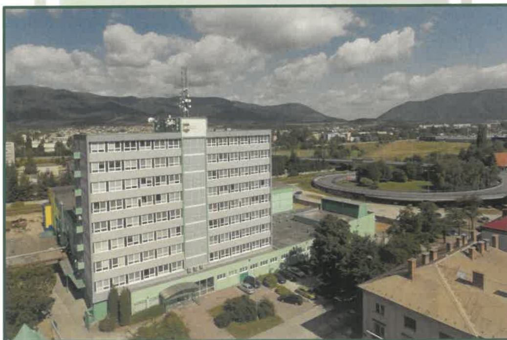
Pohľad na administratívnu budovu
